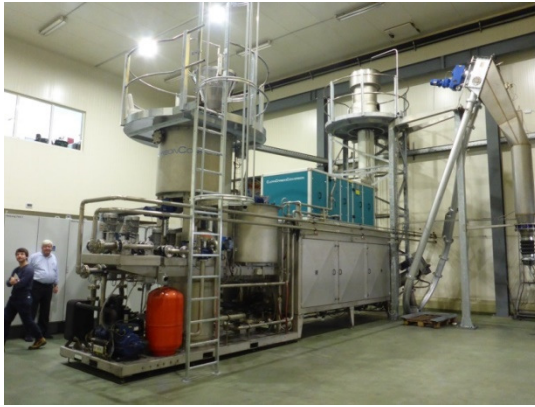
Im Dampfreaktor der Firma EXOY konnte Blei auskondensiert werden.
